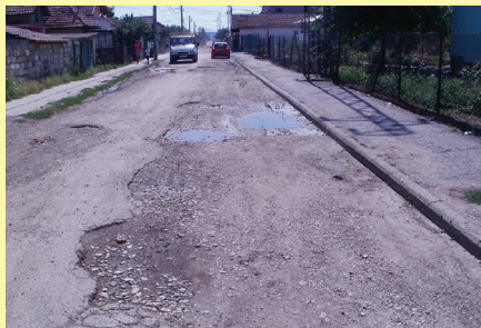
Ул. „Ломска“ преди ремонта
