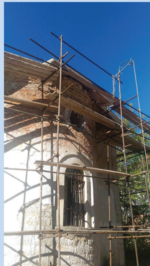
Ремонт на църквата
