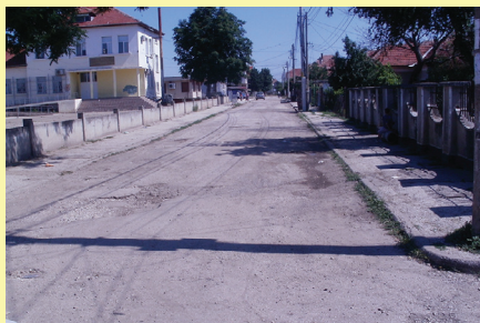
Ул. „Струга“ преди ремонта
