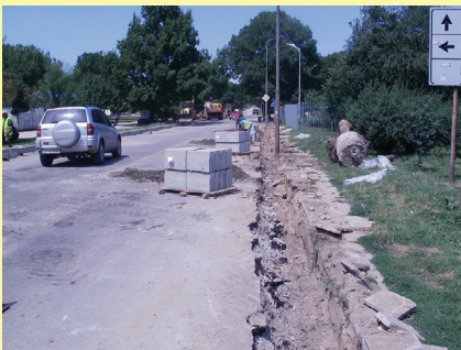
Ремонт на тротоари на ул. „Васил Левски“ до Каменния мост
