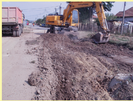
Ул. „Родопи“ в гр. Бяла Слатина по време на ремонта
