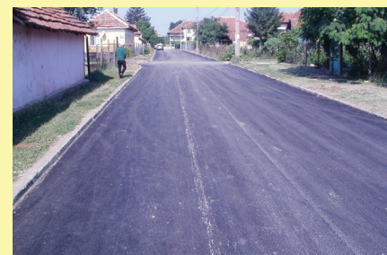
Ул. „Здравец“ след ремонта
