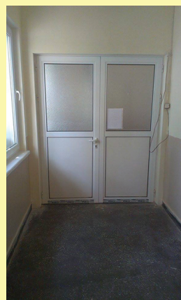
Сграда на кметството в с. Враняк след ремонт
