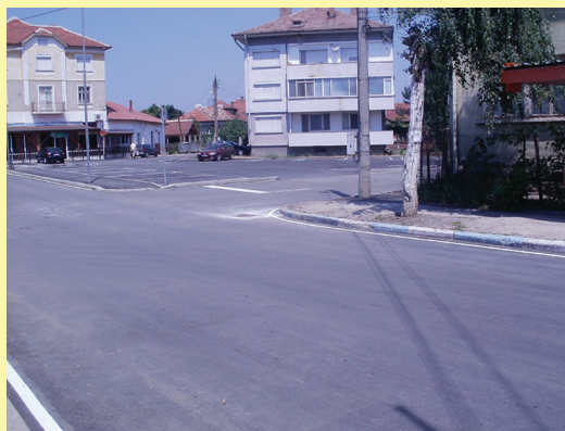
Кръстовище на ул. „Хан Крум“ и ул. „Водотечна“ след ремонта
