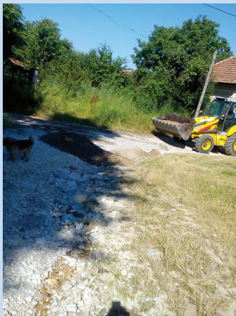
Ремонт на пътната настилка
