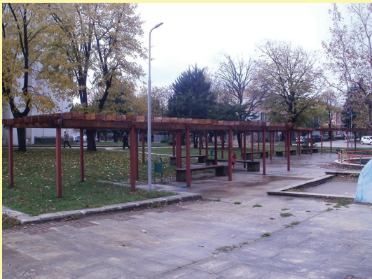
Ремонтираните перголи пред Културния дом
