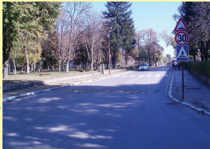
Ограничител на ул. „Климент Охридски“ в гр. Бяла Слатина
