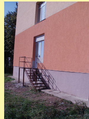
Изградена евакуационна метална стълба
