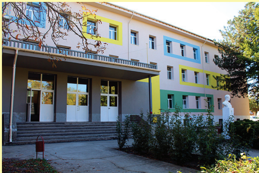
Сграда на ПАГ „Н. Й. Вапцаров“, гр. Бяла Слатина след ремонт
