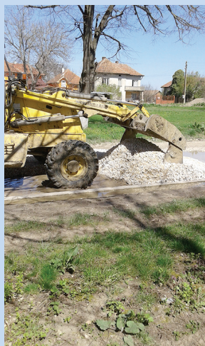
Ремонт на улица
