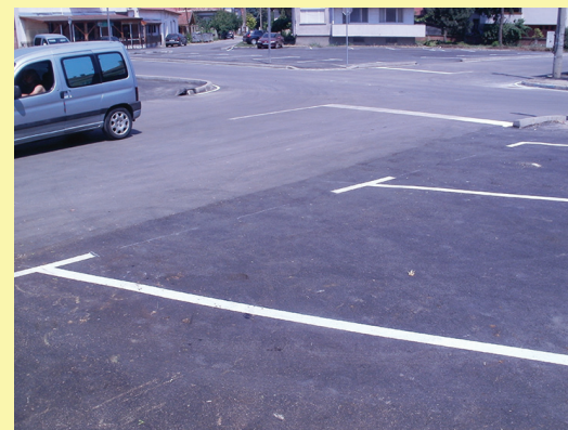
Ремонтираното кръстовище на ул. „Хан Крум“ и ул. „Водотечна“ след ремонта
