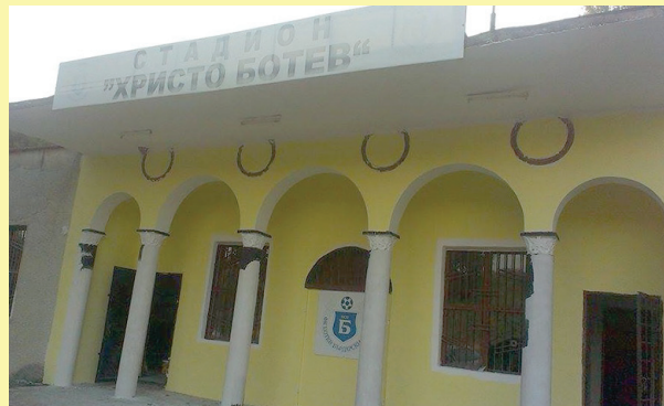
Ремонт на фасадата на съблекалнята на стадиона в с. Бърдарски геран
