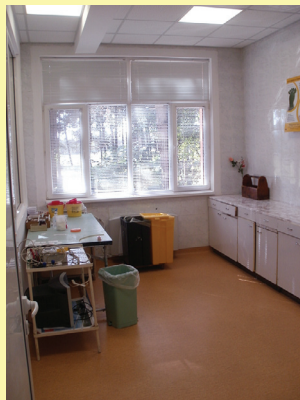
Кабинет в МБАЛ - Бяла Слатина след ремонта
