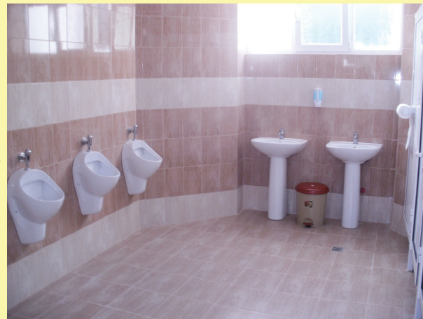
Ремонт на санитарен възел в Културния дом
