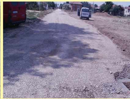
Ремонтираната ул. „Родопи“ в гр. Бяла Слатина
