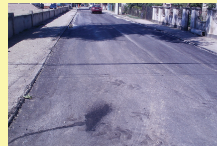
Ул. „Струга“ след ремонта
