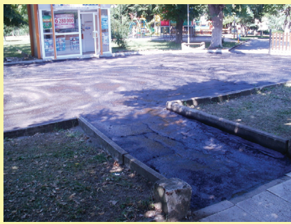
Паркова алея на ул. „Климент Охридски“ преди ремонта
