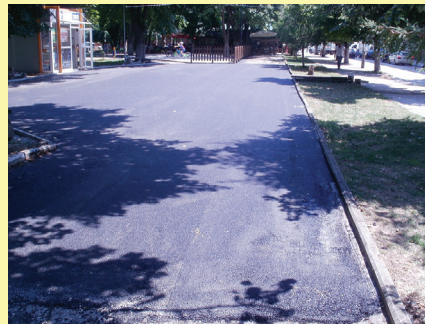
Парковата алея на ул. „Климент Охридски“ след ремонта
