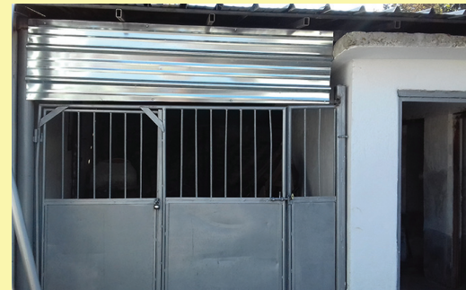
Ремонтираният навес в ОП „Чистота и строителство“
