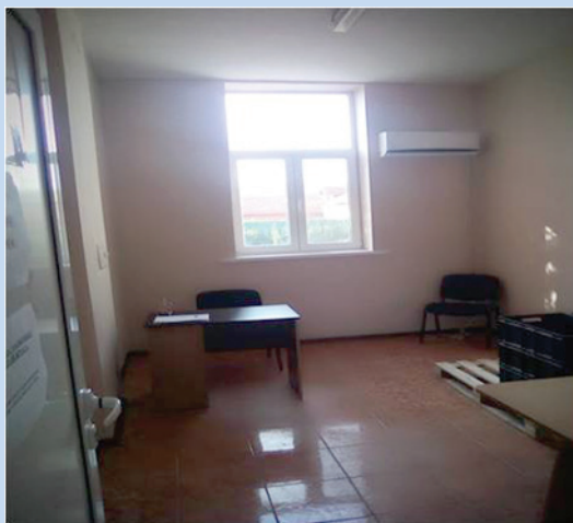
Частичен ремонт на кметството
