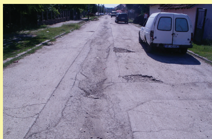
Ул. „Здравец“ преди ремонта
