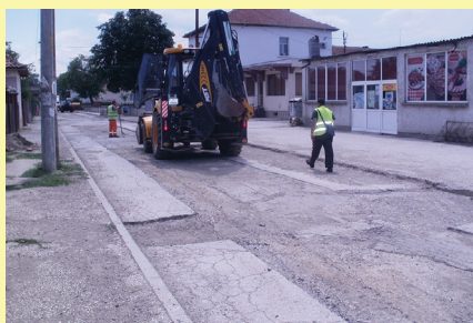
Ул. „Струга“ по време на ремонта
