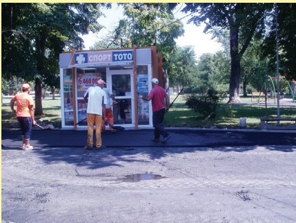
Ремонт на паркова алея на ул. „Климент Охридски“ преди ремонта
