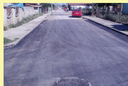
Ул. „Ломска“ след ремонта
