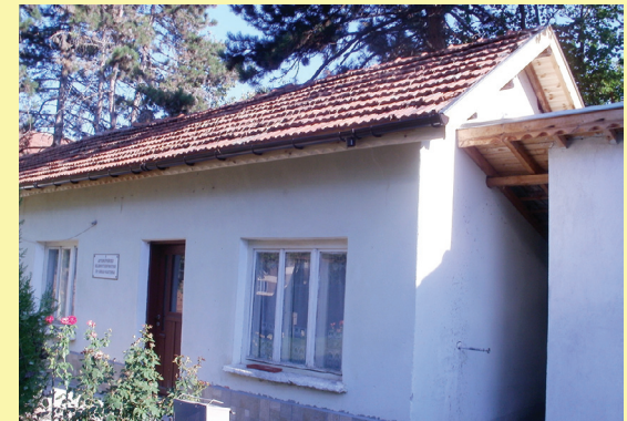
Прицърковни сгради към православен храм „Св. Параскева“, гр. Бяла Слатина след ремонта
