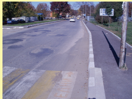
Ремонтираните тротоари на ул. „Васил Левски“ до Каменния мост
