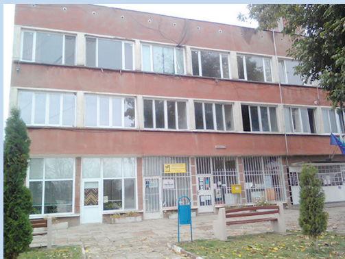
Кметството след ремонта
