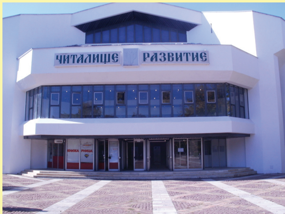
Външната фасада на НЧ „Развитие 1892“, гр. Бяла Слатина след ремонта
