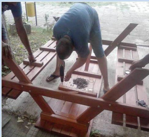
Ремонт на детски площадки
