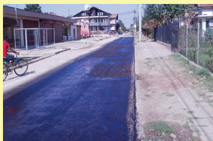
Ул. „Здравец“ по време на ремонта
