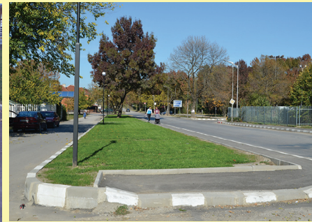
Тротоарите на ул. „Васил Левски“ до Каменния мост след ремонта
