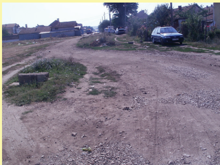
Ул. „Родопи“ преди ремонта
